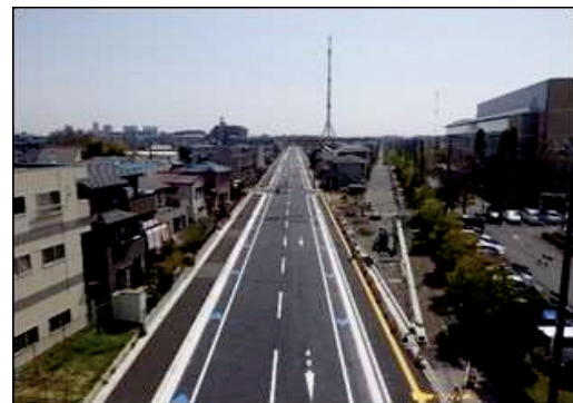
大谷場高木線（道場工区） 新設整備
