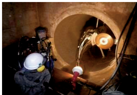
下水道管とマンホールの継手部耐震化
