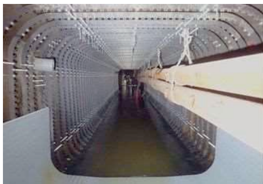
老朽化した下水道管の更生
