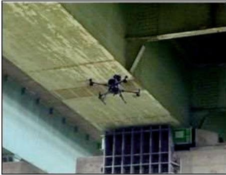
ドローンによる橋りょう点検
